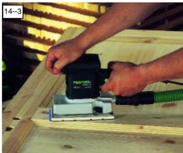
Es ist sinnvoll die Oberfläche der Füllung vor dem Verleimen zu behandeln. Da eine Massivholzfüllung schwinden kann, würden beim Zusammenziehen der Füllung unbehandelte Flächen sichtbar werden.
