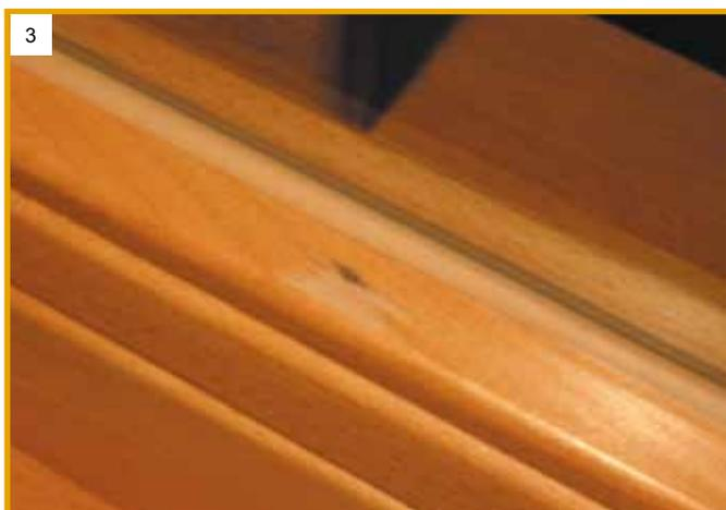
(2) Größere Druckstellen oder sogar Löcher im Holz können mit Wachs geschlossen werden. Dieses Wachs kann mit Hilfe eines Feuerzeuges in die Fehlstelle hineingeträufelt werden, und muss dann anschließend mit einem Stecheisen beigestochen werden.
